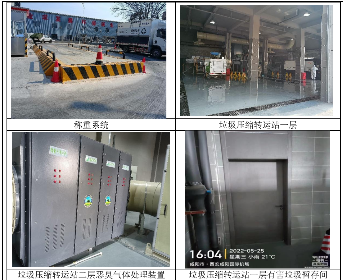
图 2-1 垃圾压缩转运站项目现场照片
