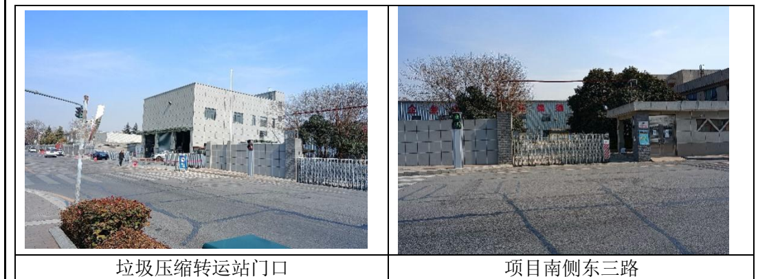
垃圾压缩转运站项目现场照片见图 2-1。
