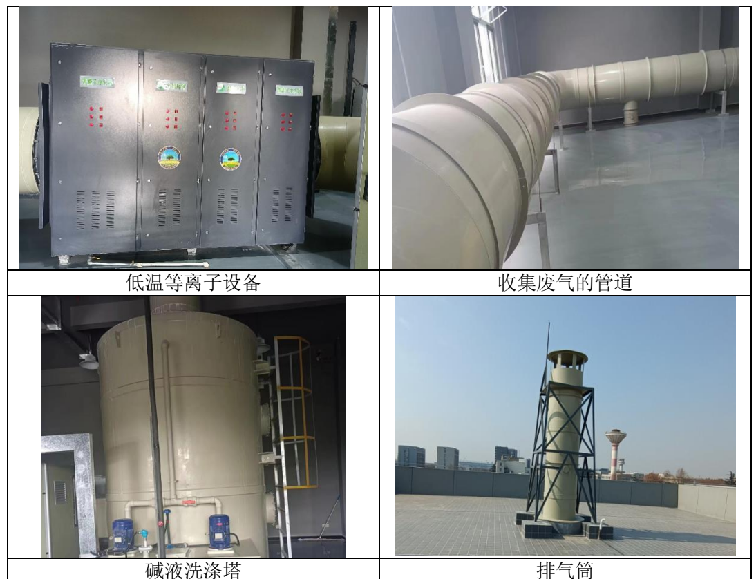
图 3-1 废气处理流程图
